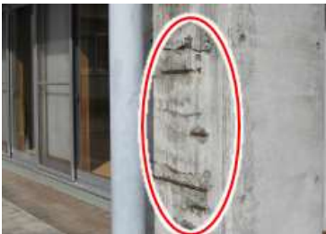
□コンクリート柱の破損、白華
