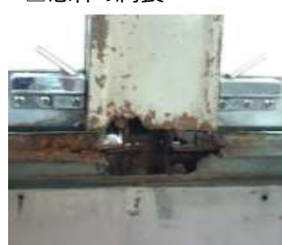
窓枠の腐食
